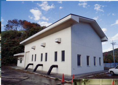
菅又揚水機場
